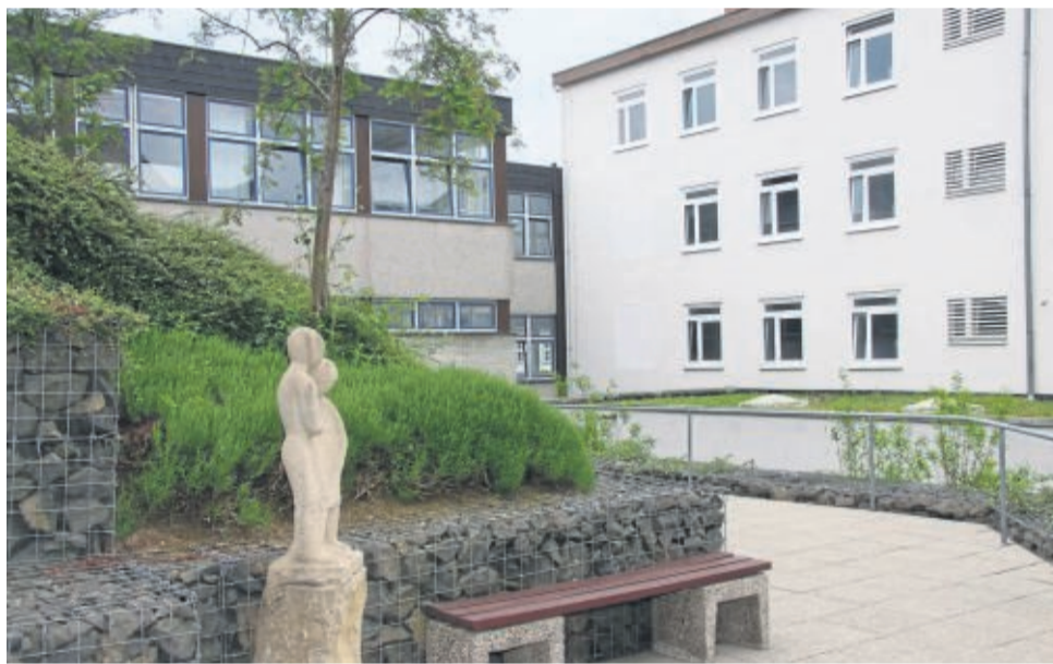
Blick aus dem Therapiegarten auf das Evangelische Krankenhaus Gesundbrunnen in Hofgeismar. Das Haus strebt eine vertiefte Zusammenarbeit mit den Agaplesion Diakonie Kliniken Kassel an.
